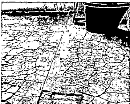
Foto 1: Piso actual en mal estado de aula No. 1 de 5, móvil con base de metal.
